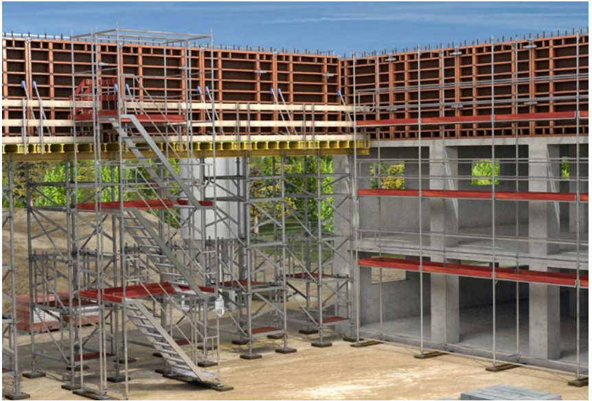
Abb. 12 Verkehrsweg an und auf Tragkonstruktion.
