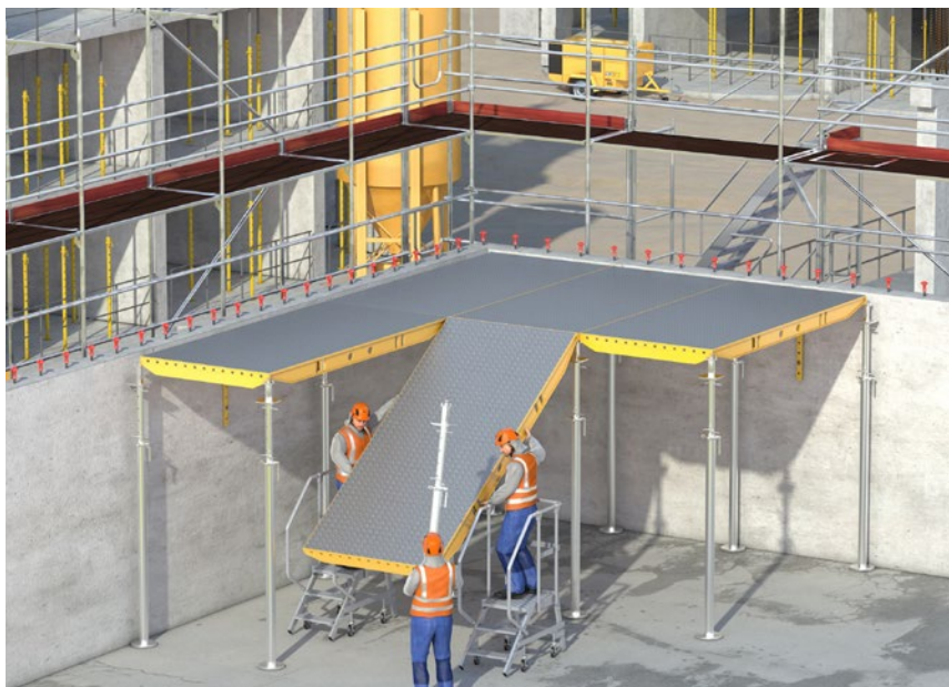
Abb. 6a Aufbau von Deckenschalungssystemen mittels Podesttreppe
