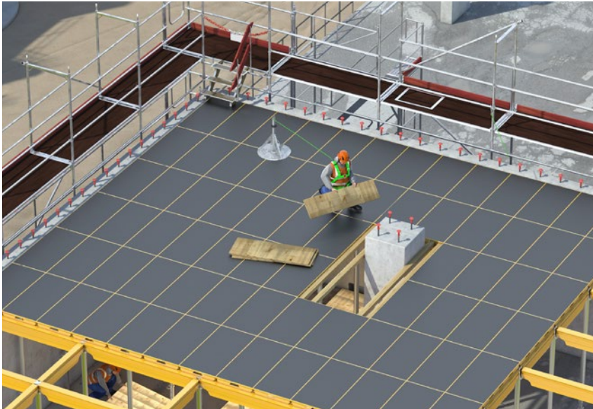
Abb. 7a Aufbau von Deckenschalungssystemen unter Verwendung von PSaG bei vorhandener Störstelle (Stützendurchbruch durch Deckenpaneele)
