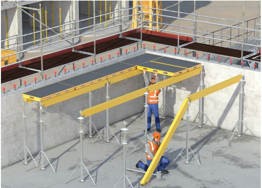
Abb. 5 Aufbau eines Deckenschalungssystems aus einer gesicherten Standposition.
