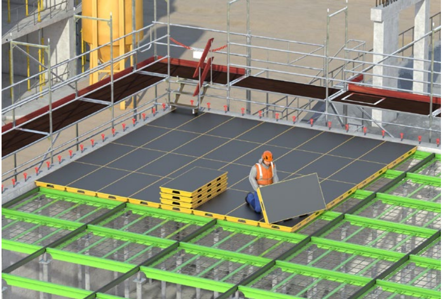
Abb. 6c Aufbau von Deckenschalungssystemen mittels eingelegten Gitterelementen
