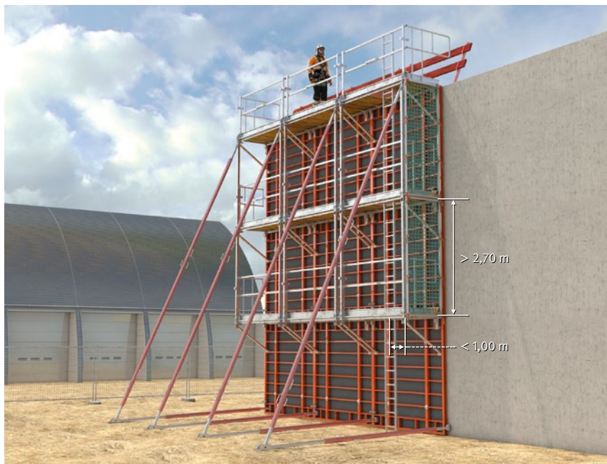
Abb. 3 Absturzsicherung und Zugang an einer Wandschalung
